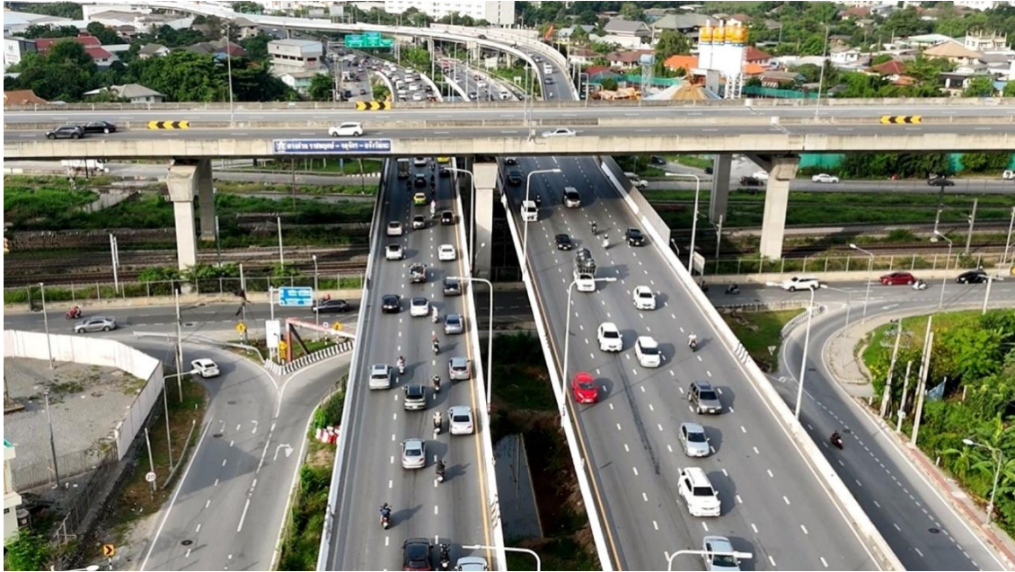
สภาพปัจจุบันสะพานข้ามทางรถไฟบนถนนราชพฤกษ์บริเวณจุดตัดทางพิเศษประจิมรัถยา
