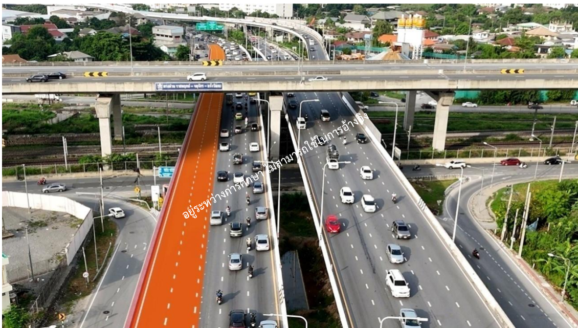
สภาพสะพานข้ามทางรถไฟบนถนนราชพฤกษ์บริเวณจุดตัดทางพิเศษประจิมรัถยาหลังปรับปรุง รูปที่ 6-1 รูปแบบการปรับปรุงสะพาน - ทางเลือกที่ 1 ขยายสะพานเดิม
